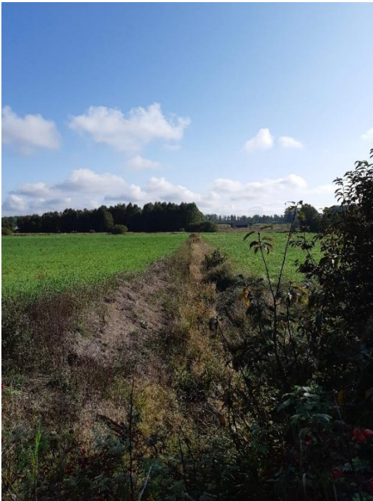
Figur 16 och 17. Dike 12 med blottad sandbank, samt dike 28 med naturlig, opåverkad sträcka närmast banvallen.
